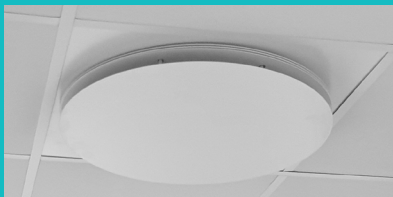
Det reaktiva taktilluftsdonet MTC-400 med fast underplåt. Donet saknar egen aktiv styrning men har en spaltöppning som ökar och minskar med luftflödet. Det reaktiva taktilluftsdonet MTN-400 finns som alternativ till MTC-400. MTN-400 är utrustat med en rörlig underplåt.
