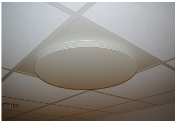
Det reaktiva tilluftsdonet MTD monterat i undertak.
