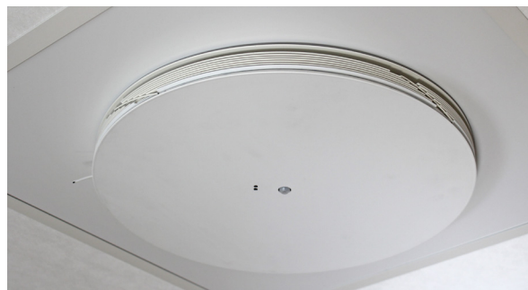
Det cirkulära aktiva taktilluftsdonet TTC med integrerad spjällmotor, regulator och närvarogivare i donet. Systemet medger variabelt luftflöde från enskilda don. Det aktiva donet finns också i en väggmonterad variant, se produktbeskrivningen för det aktiva tilluftsdonet VTD-125.
