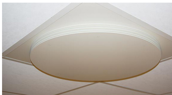
Ett cirkulärt reaktivt taktilluftsdon med lameller där spalthöjden varierar med kanaltrycket. Systemet medger variabelt luftflöde över en grupp av don anslutna till en gemensam tilluftskanal. Det reaktiva taktilluftsdonet finns i två utförande. MTC har liksom TTC en fast underplåt medan varianten MTM har en rörlig underplåt som sluter lameller samt underplåt mot taket då luftflödet minskas.
