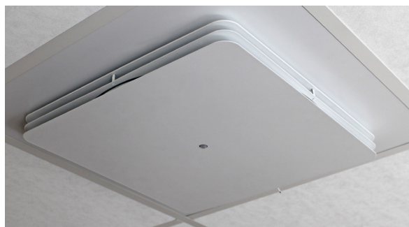
TTF monterat i undertak.
